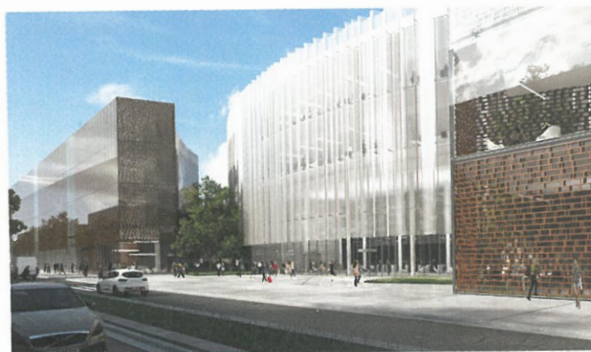
Bâtiment Servier © Wilmotte & Associés Architectes
