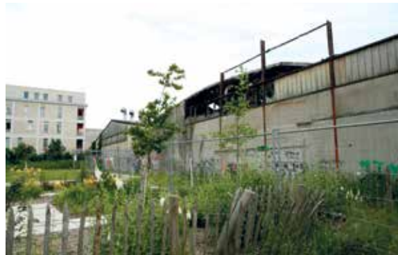
Après sa démolition, la friche de l'usine doit accueillir 290 logements. Un peu trop du point de vue de certains habitants. © Marine Dumeurger
