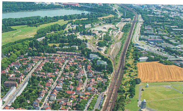
Vue sur le site du projet Freyssinet depuis Trappes-en-Yvelines © Altlicic
