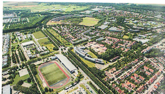
Vue sur le site du projet Saint-Quentin Est - Guyancourt © Alticio
