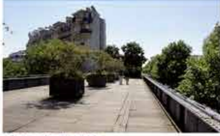
Viaduc de arts - Paris
