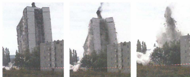
▼ Démolition de la Tour Molière, le 3 octobre 2010
