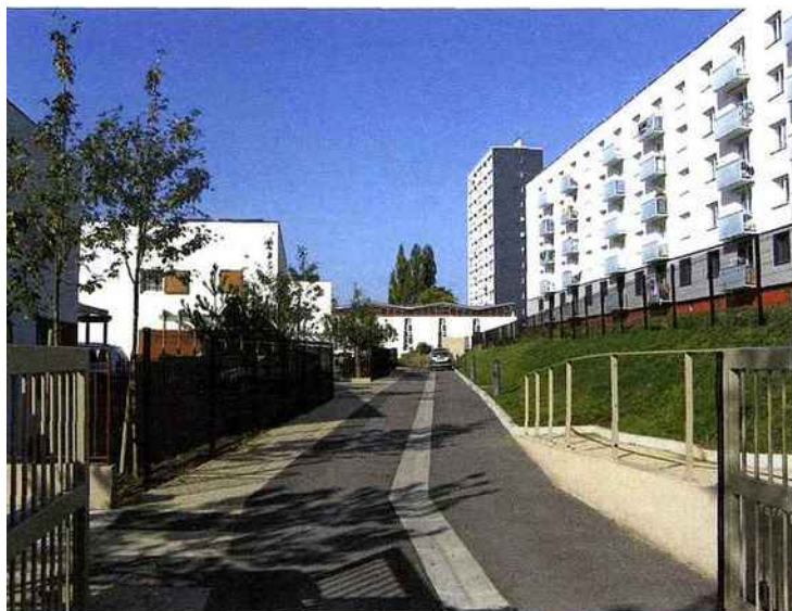
Opération de réhabilitation-résidentialisation.
