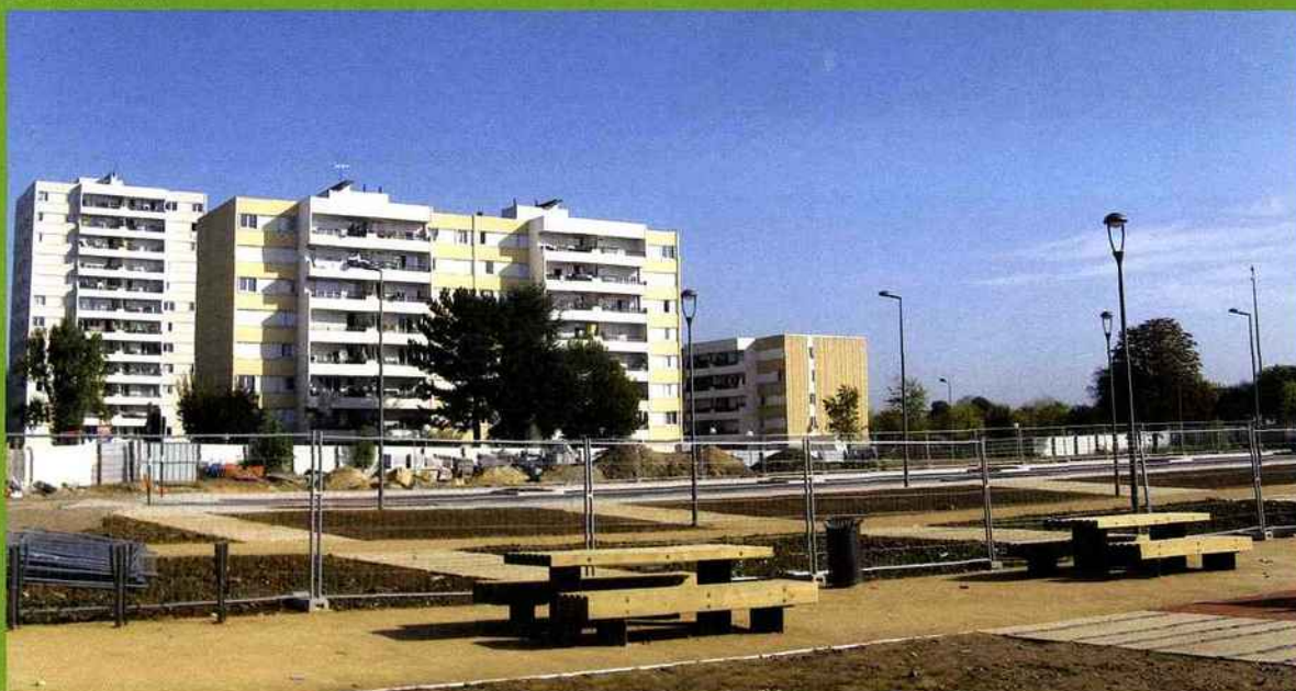
Le futur parc Molière.
