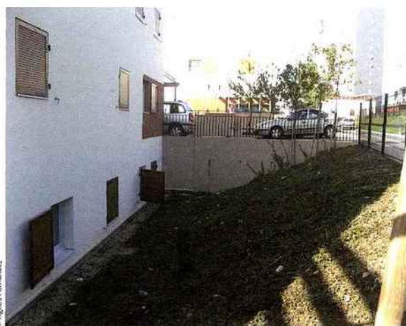
Rez-de-talus d'un immeuble de logement social.
