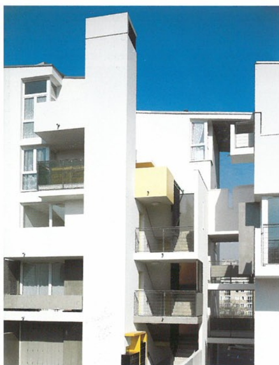
▲ Un passage est ouvert dans l'épaisseur de l'immeuble, qui relie le mail et la cour.
